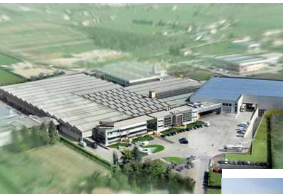
Stabilimento La Nordica Montecchio Precalcino
